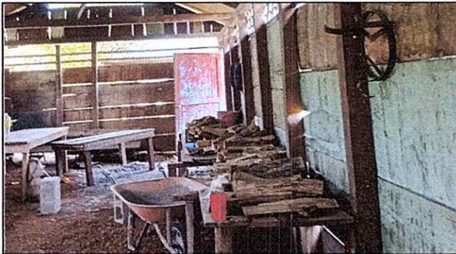
Foto 3: Parte Interna: Instalacion de piso de concreto
