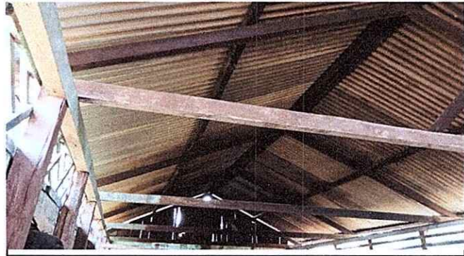
Foto 4: Sustitucion de Bigas de madera por Costaneras
