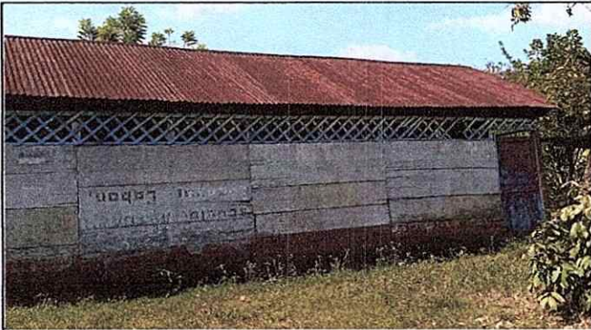
Foto1: Sustitucion de Laminas.
