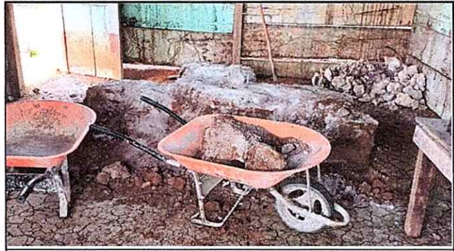
Foto 2: Parte lateral de Aula: Sustitucion de paredes y piso.
